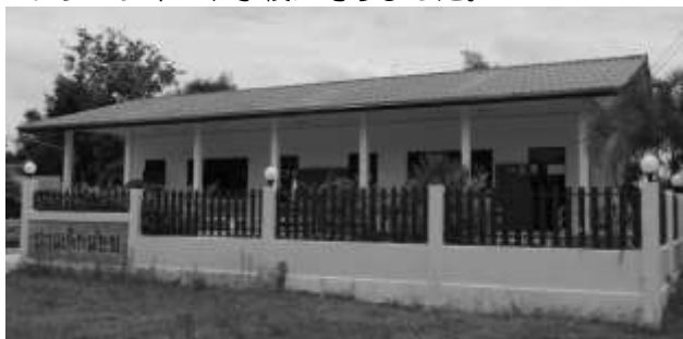
【完成した校舎】
