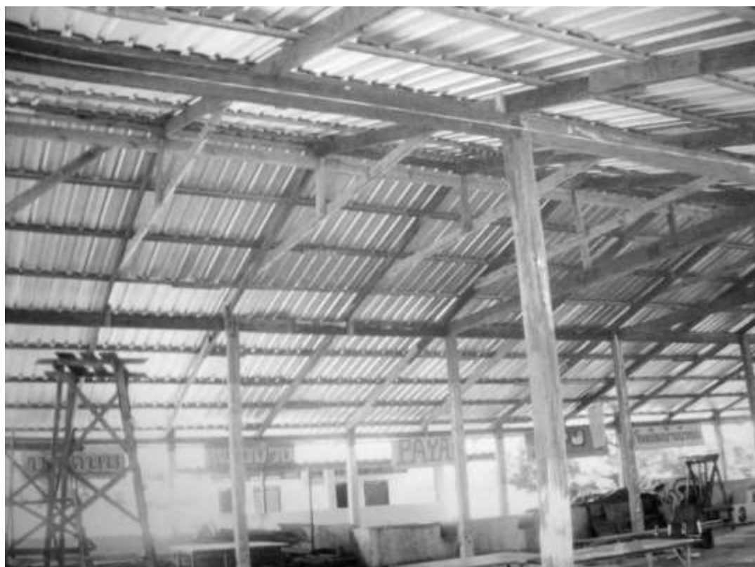
学校で途中まで建設を進めているプロジェクト
