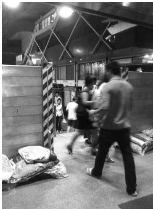
洪水対策に鉄扉を一部閉じて営業を続ける地下鉄。
