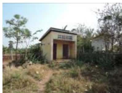
学校にあるトイレはこの2部屋だけ
